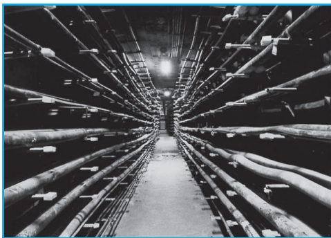
照片 4.1 电缆隧道
